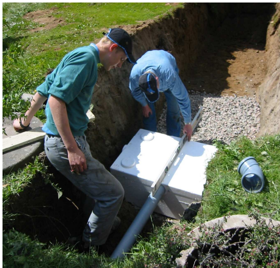
Installation av kompaktfilter. Källa:
