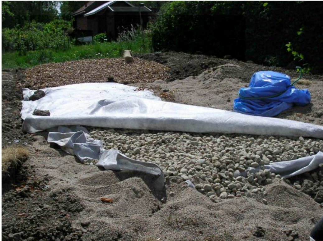
Figur 4. Filterbädden för duschvattenrening under byggnation maj 2007.
